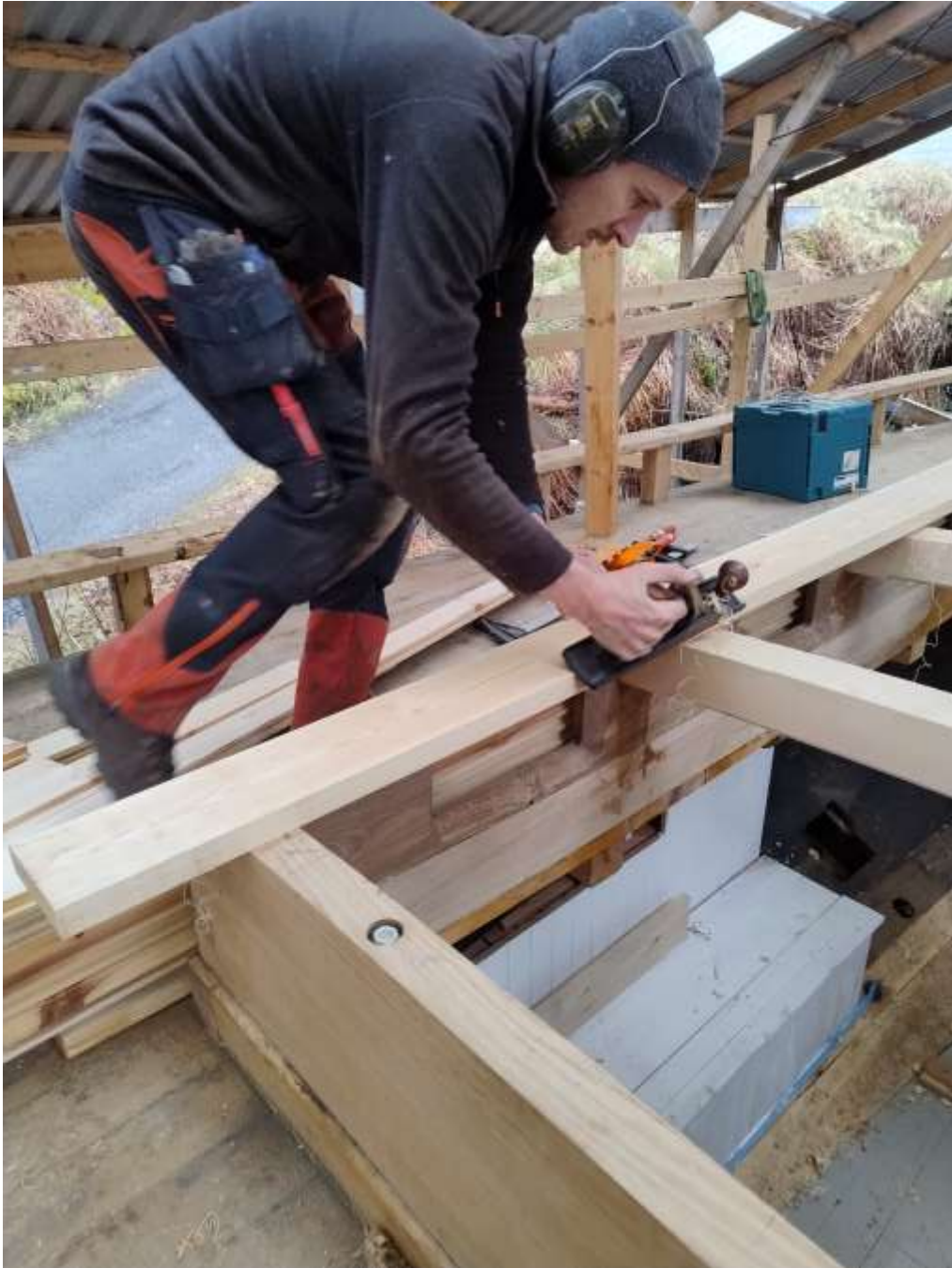
Håndhøvling av fas på bordene til rufftaket.
